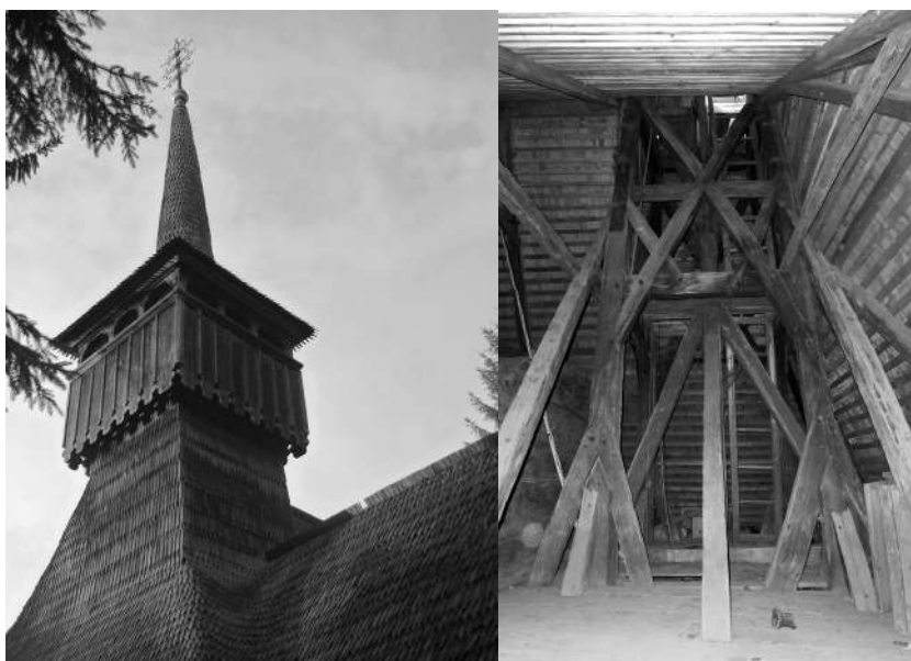
Călinești Căeni church of Holy Virgin Birth, the tower and its construction inside attic. Biserica Nașterea Maicii Domnului din Călinești Căeni, turnul și structura sa sub acoperiș.
