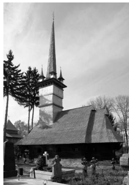
Church " Saint Ana" in Coruia, before and after restoration: Facade with main acces with ruined fundamentele și învelitoarea grav deteriorate, respectiv fațada laterală cu absida altarului.
