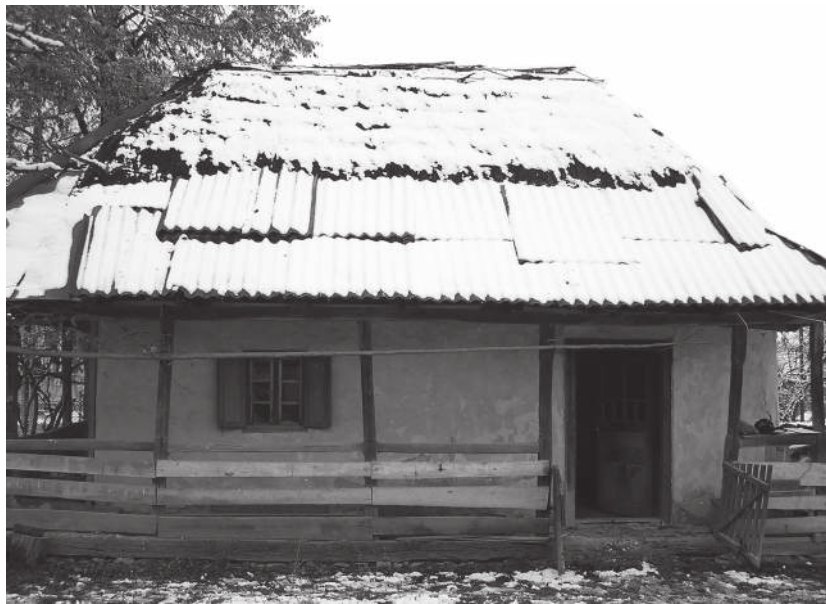
Fațada spre curte - Courtyard facade
