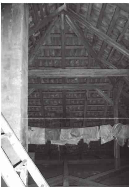
Podul uriaș, cu structură independentă. / L.Z.2014 The huge bridge, an independent structure. / L.Z.2014
