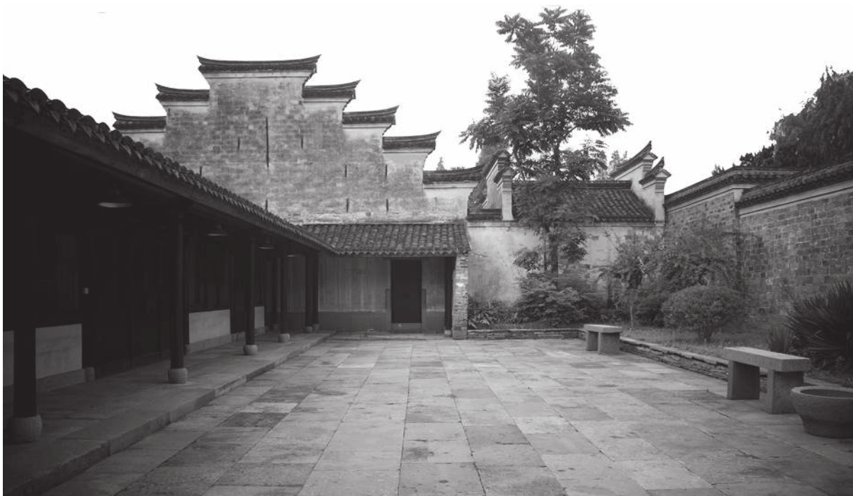
P9) Pardoseală acoperită cu plăci din piatră în casa FengYu P9) Slates Ground in FengYu's House
