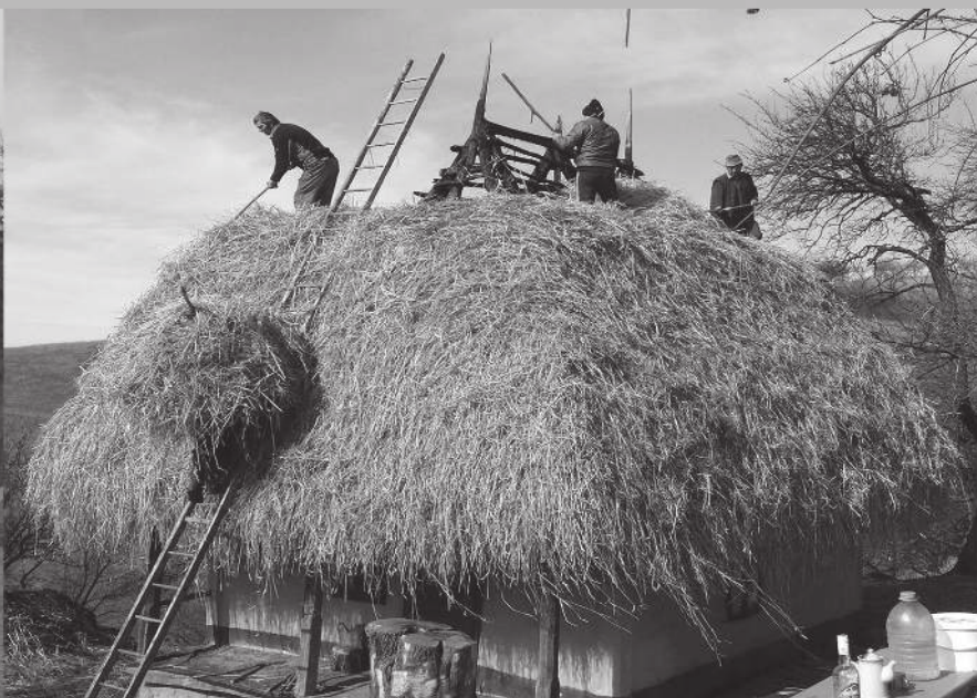
Acoperiș de paie refăcut pentru o casă din Preluca Nouă
