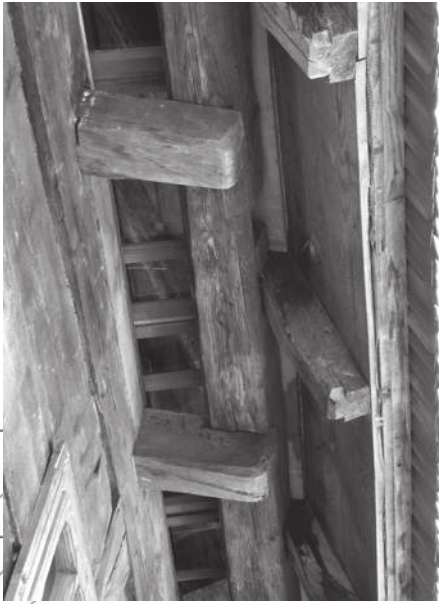
Foile ferestrelor vechi montate la streșină / M.E. Old window leaves on the eaves / M.E.
