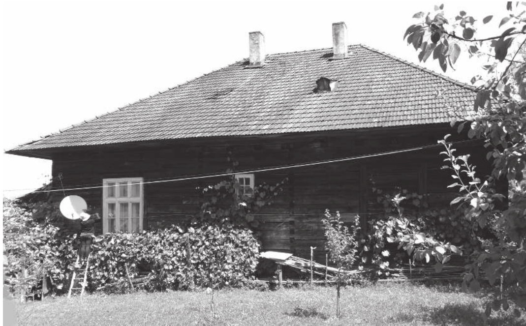
Fațada posterioară, pe care se văd îmbinările nemțești în lungul bânelor („șărași”). / L.Z.2014 Rear side, on which one can see the German junctions, lengthwise the beams. („șărași”). / L.Z.2014
