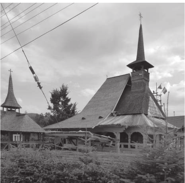
Remodelarea și extinderea unei biserici contemporane din lemn, în comuna Călinești.
