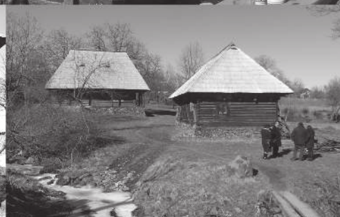
Acoperiș de draniță refăcut pentru o gospodărie din Breb
