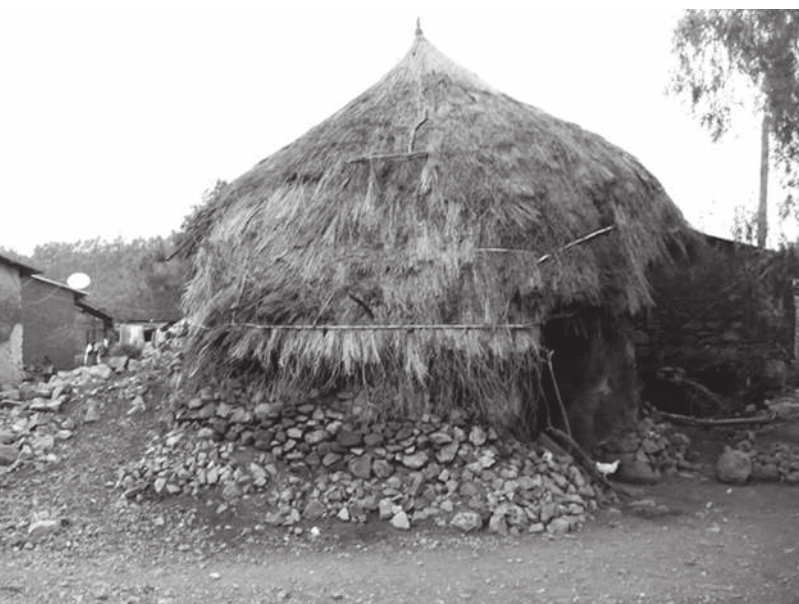
Casă circulară vernaculară cu acoperiș din paie. Vernacular circular house with thatched roof.
