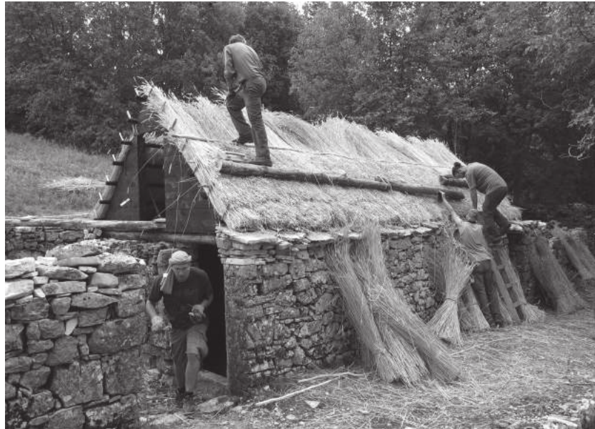
Casa de piatră din satul Petrebišća. Fotografia reprezintă refacerea acoperișului de paie, în timpul unui workshop în Dragodid. / Grga Frangeš
