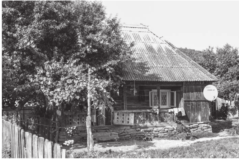
Casa cu nr. 247 / House nr. 247
